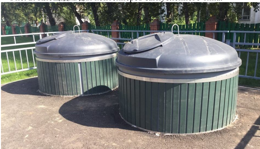
Рис. 2. Площадка для контейнеров заглубленного типа.
