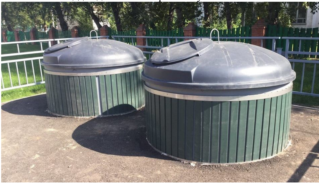
Рис. 2. Площадка для контейнеров заглубленного типа.
